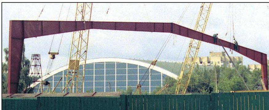
Рисунок 1.7.5 – Стальная рама для кровли крытого катка в процессе монтажа, г. Вильнюс, Литва (фото Д. Д. Жукова)
