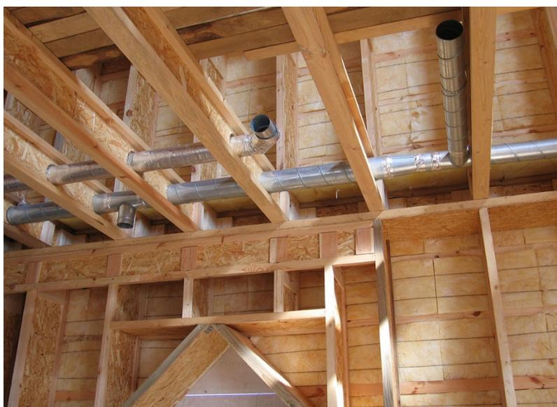
*Рисунок 1.4.6 – В том же доме (см. рисунок 1.4.5) сочетание балок перекрытия и воздуховодов системы вентиляции (фото Д. Д. Жукова)*
