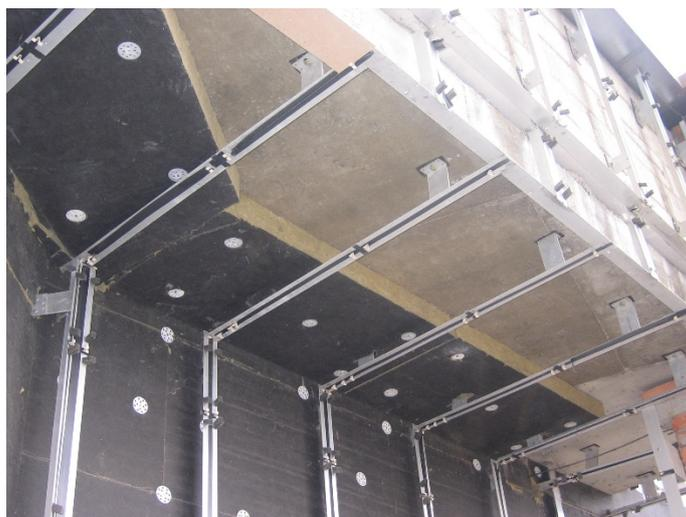
Рисунок 1.2.7 – Монтаж вентфасада с каркасом облицовки из алюминиевых профилей (фото Д. Д. Жукова)
