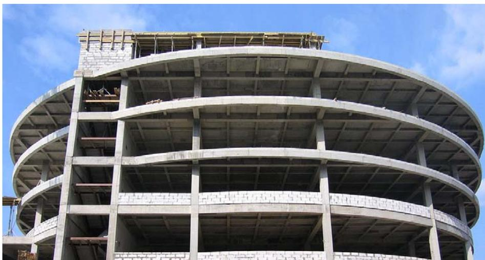
*Рисунок 1.1.33 – Многоэтажное общественное здание с монолитным железобетонным каркасом и ребристыми перекрытиями в процессе строительства в г. Минске (фото Д.Д. Жукова)*
