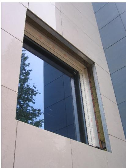
*Рисунок 1.2.8 – Монтаж вентфасада с облицовкой из керамогранитных плит
