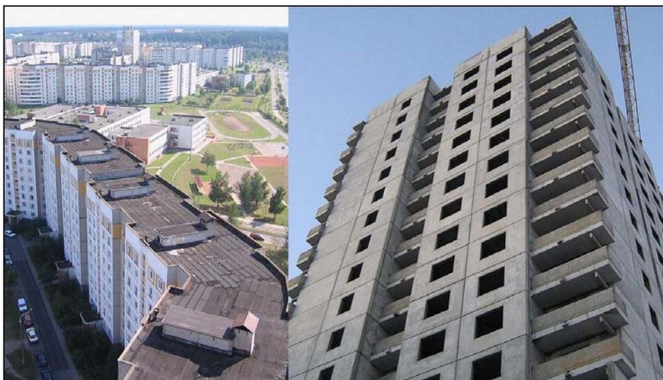
Рисунок 1.8.1 – Крупнопанельные жилые дома производства ОАО «МАПИД»: 9-этажный с плоской крышей и теплым чердаком (слева) и 19-этажный во время строительства (справа), г. Минск (фото Д. Д. Жукова)
