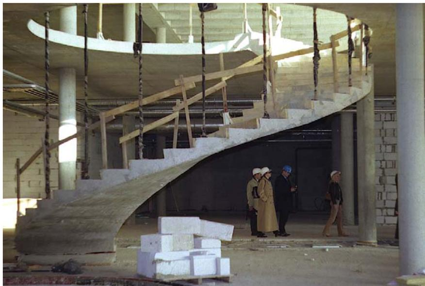
*Рисунок 1.5.22 – Монолитная железобетонная основа парадной лестницы общественного здания в г. Вильнюсе, Литва (фото Д. Д. Жукова)*
