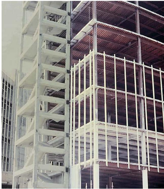
*Рисунок 1.5.4 – Стальной каркас здания бизнес-центра «XXI век»; на стальные двутавровые балки перекрытий уложен профилированный настил, на который залит слой бетона; к стальному каркасу примыкают сборные железобетонные конструкции незадымляемой лестничной клетки (фото Д.Д. Жукова)*
