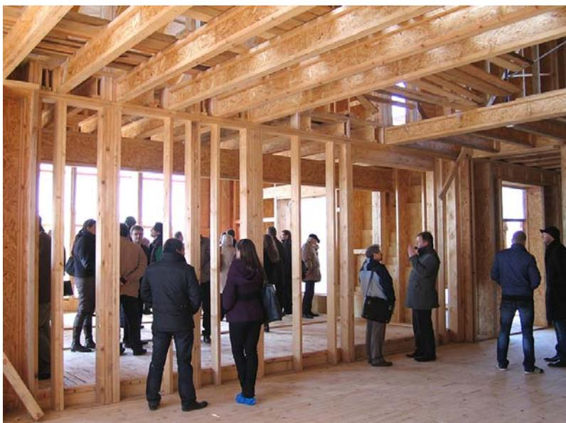
*Рисунок 1.4.5 – Несущий остов двухэтажного мультикомфортного дома в г. Дзержинске Минской области; двутавровые балки перекрытия имеют стенку из ориентированно-стружечной плиты и деревянные полки (фото Д. Д. Жукова)*
