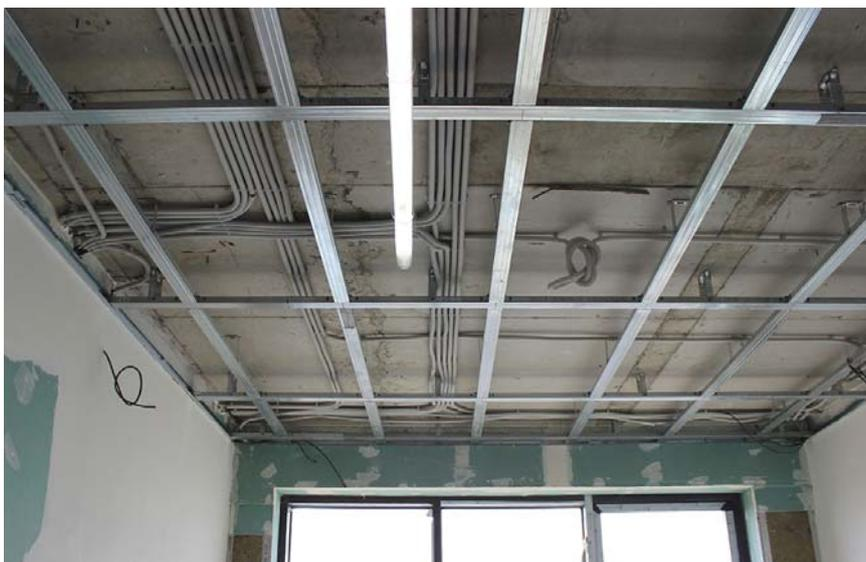
Рисунок 1.4.9 – Подвесной потолок с ограждением из гипсокартонных плит в процессе монтажа (фото Д. Д. Жукова)
