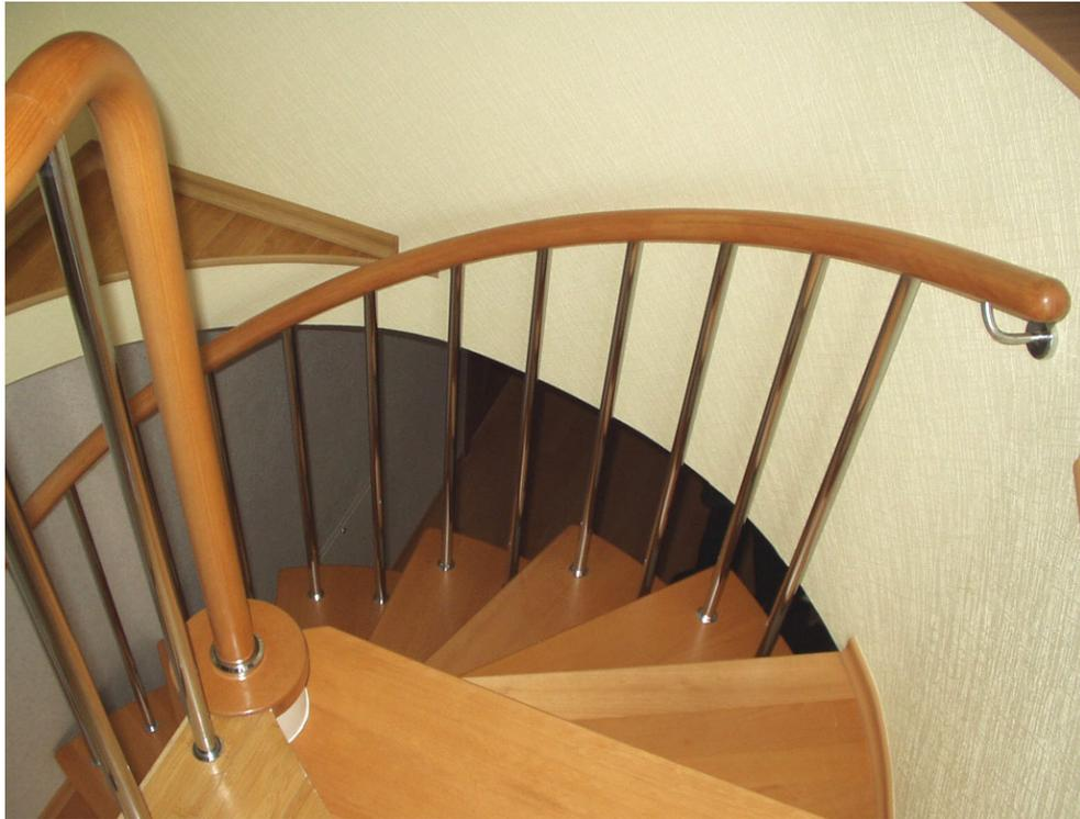
*Рисунок 1.2.25 – Деревянная винтовая лестница*
