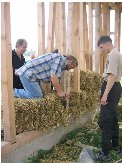
*Рисунок 1.2.14 – Заполнение каркаса наружной стены соломенными блоками
