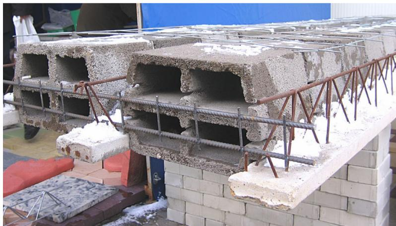
Рисунок 1.4.2 – Сборно-монолитное балочное перекрытие, элементы без бетона замоноличивания (фото Д. Д. Жукова)
