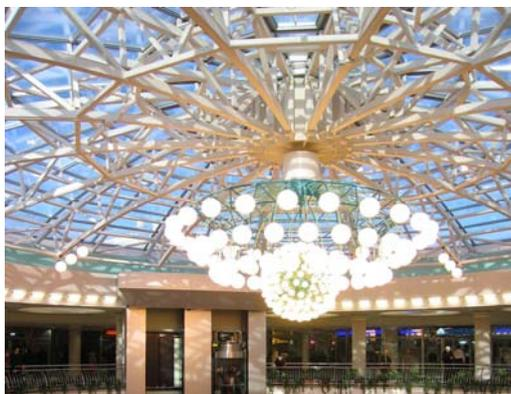
Рисунок 1.6.10 – Стеклопанельная купольная крыша ТЦ «Столица», г. Минск (фото Д. Д. Жукова)
