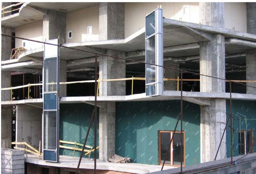
*Рисунок 1.5.16 – Начало монтажа изготовленных на заводе легких навесных панелей со светопрозрачной частью в случае монолитного железобетонного каркаса, г. Киев, Украина (фото Д. Д. Жукова)*
