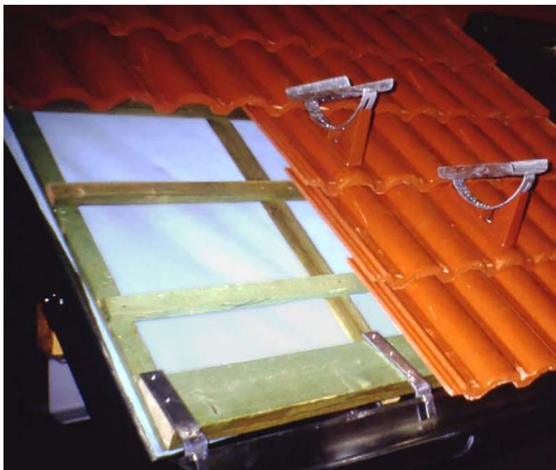
Рисунок 1.4.20 – Кровельная конструкция с водоизоляцией из керамической черепицы (фото Д. Д. Жукова)
