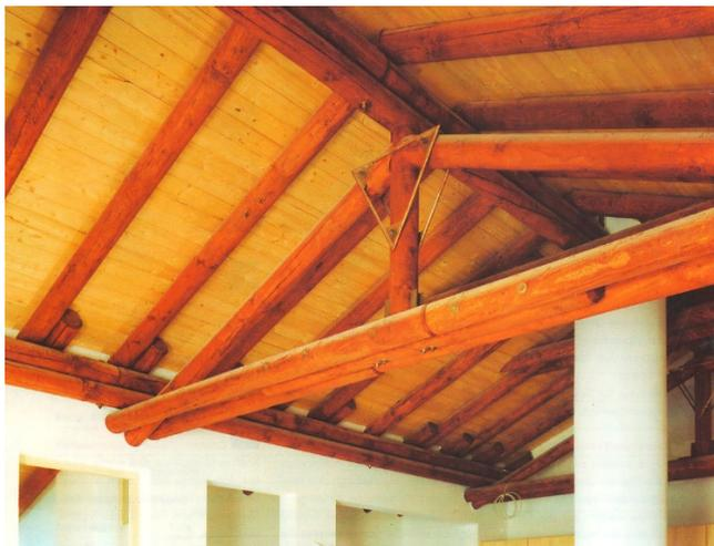
Рисунок 1.4.15 – Висячие стропила из оцилиндрованных бревен (фото компании Grünzweig + Hartmann AG, Германия)
