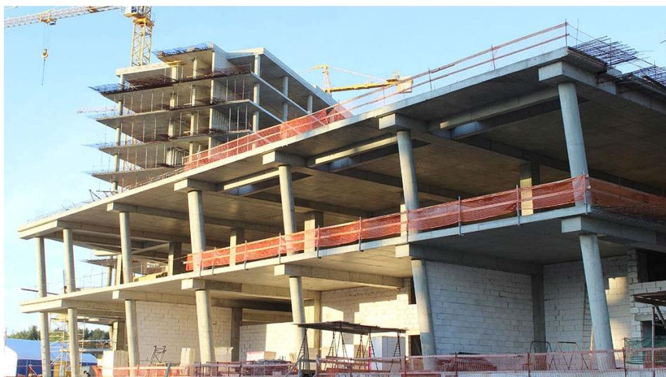
*Рисунок 1.5.8 – Монолитный железобетонный каркас строящегося здания, г. Минск
