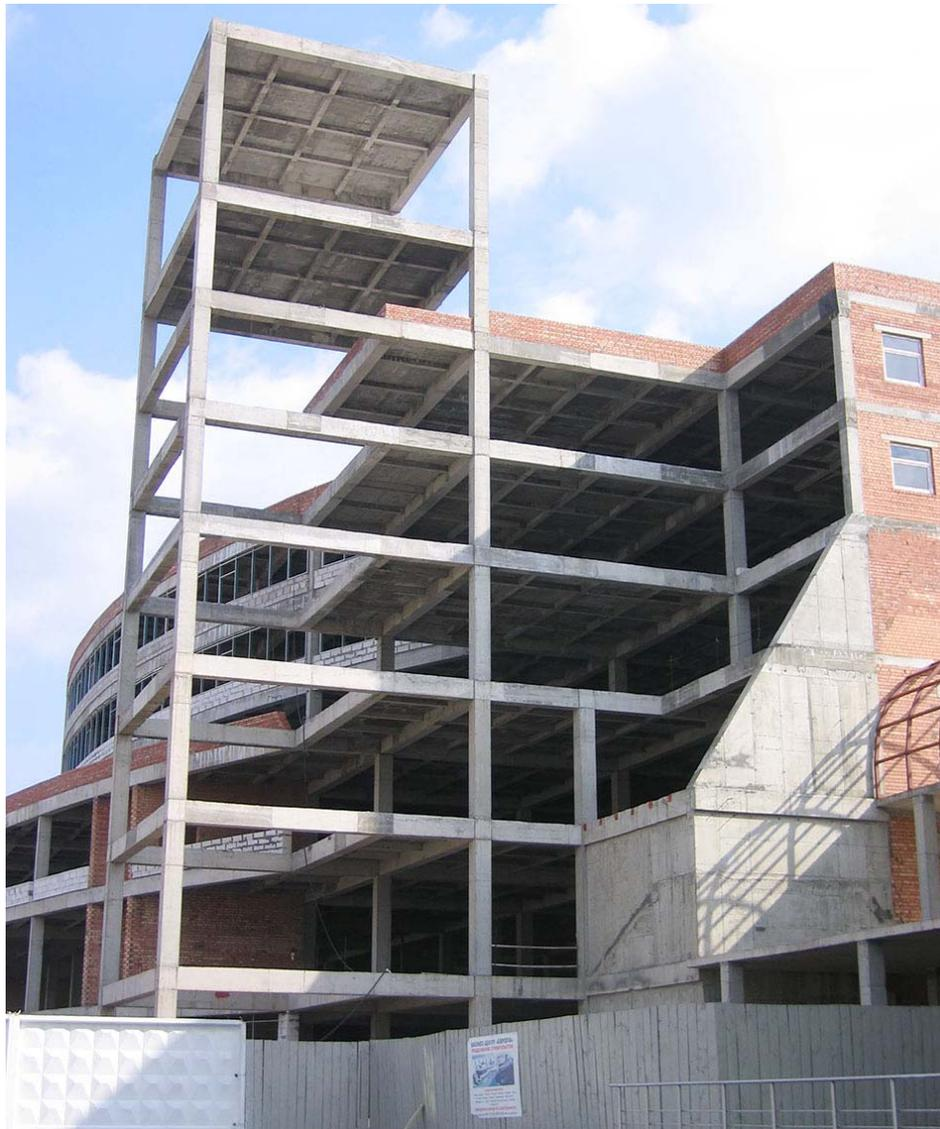
Рисунок 1.5.14 – Строящееся здание с монолитным железобетонным рамно-связевым каркасом, г. Минск (фото Д. Д. Жукова); перекрытия – кессонные
