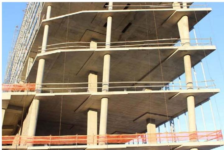
*Рисунок 1.5.1 – Строящееся здание с монолитным железобетонным каркасом, имеющим условно плоские диски перекрытий, г. Минск (фото Д. Д. Жукова)*
