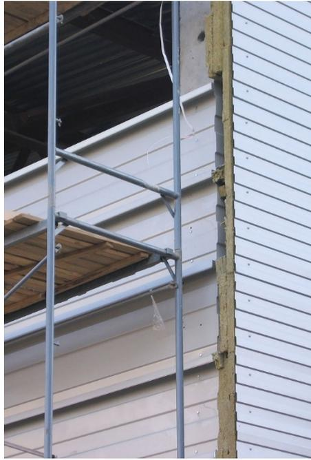
*Рисунок 1.5.17 – Легкие навесные стены на основе сэндвич-профиля в процессе монтажа в случае здания с железобетонным и стальным каркасом, г. Минск (фото Д. Д. Жукова); теплоизоляция из минераловатных плит, наружная облицовка из металлического сайдинга*
