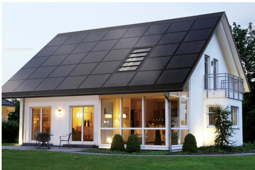
*Рисунок 1.2.2 – Nearly zero-energy building с крышной фотоэлектрической системой в Германии (фото компании ibbink)*
