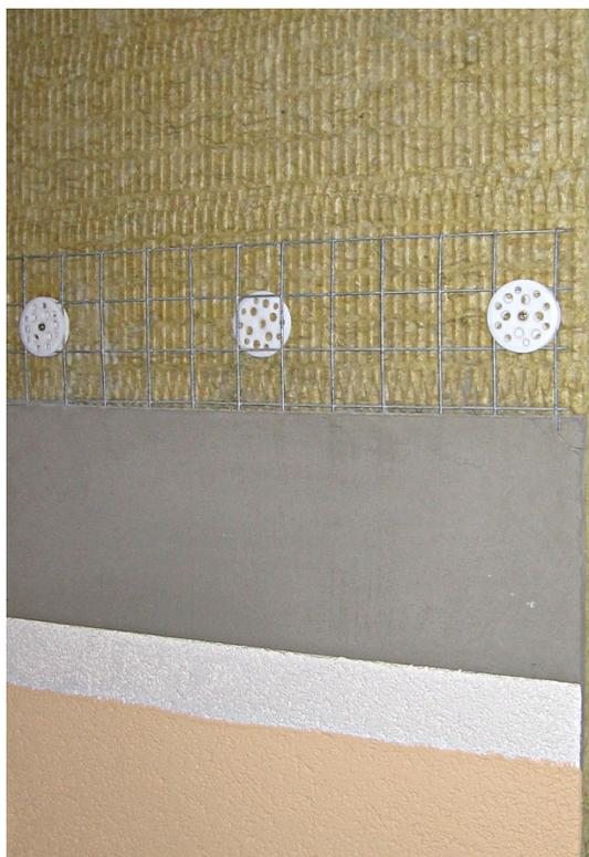
Рисунок 1.2.5 – Макет тяжелой штукатурной системы утепления (фото Д.Д. Жукова)
