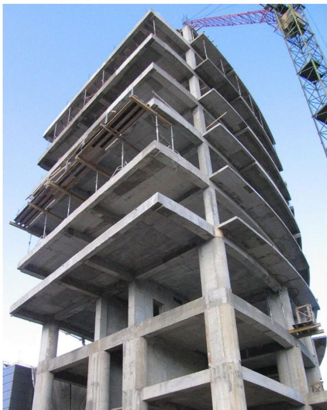
*Рисунок 1.5.2 – Строящееся здание с монолитным железобетонным каркасом, имеющем усиленные ребрами (балками) перекрытия, г. Минск (фото Д. Д. Жукова)*
