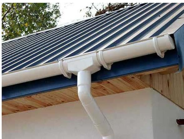
Рисунок 1.4.23 – Водосточная система из поливинилхлорида (фото компании *Plastmo Polska*, Польша)
