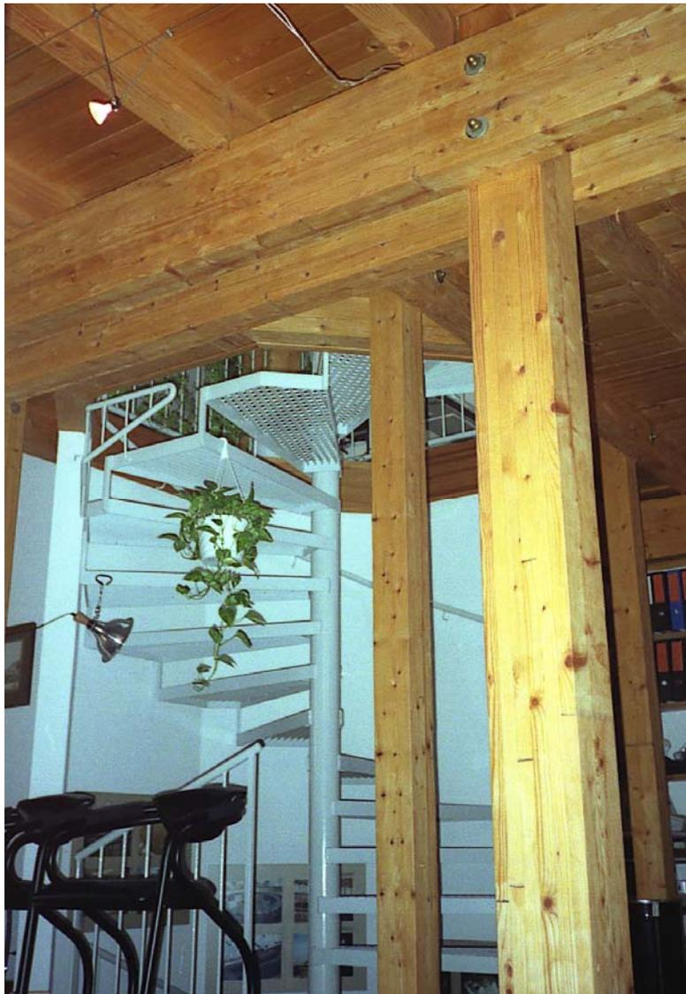
*Рисунок 1.2.24 – Металлическая винтовая во вращающемся энергоактивном доме, экологическая древесина г. Райне, Германия (фото Д. Д. Жукова)*
