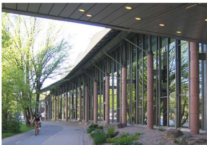
*Рисунок 1.6.18 – Фасад здания с наружным каркасом, г. Гётеборг, Швеция
