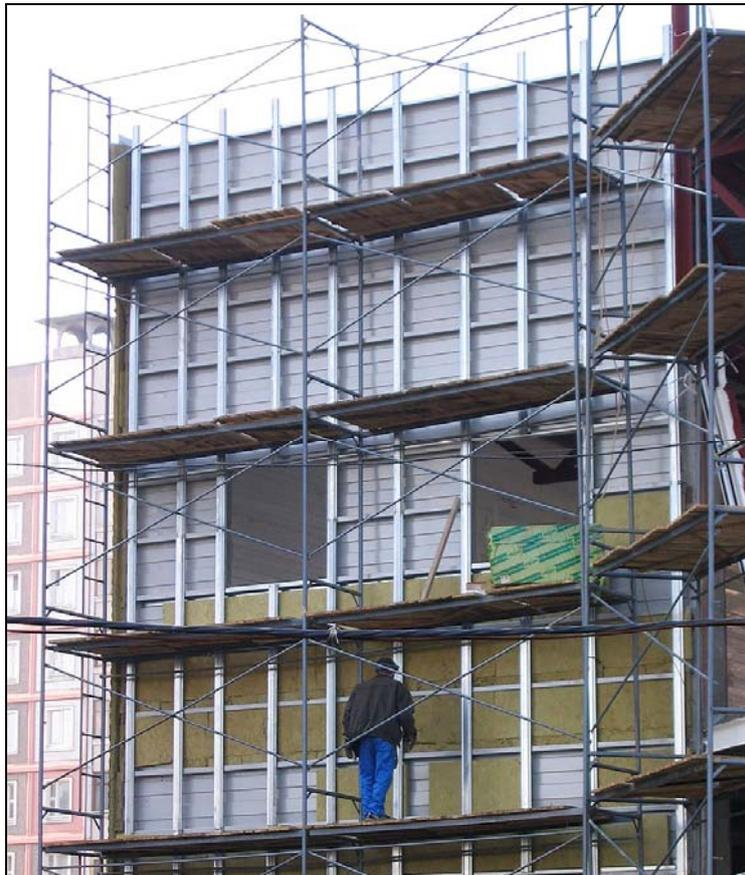
*Рисунок 1.5.18 – Легкие навесные стены на основе сэндвич-профиля в процессе монтажа в случае здания с железобетонными и стальным каркасом, г. Минск (фото Д. Д. Жукова)*
