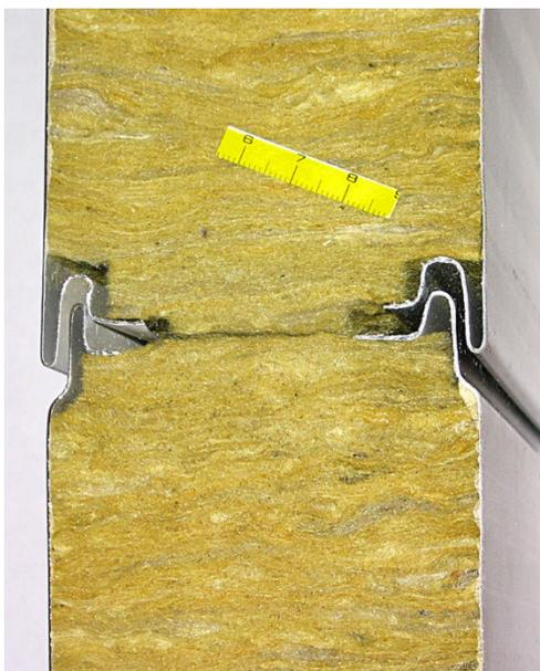
*Рисунок 1.5.15 – Сопряжение двух легких навесных сэндвич-панелей заводского изготовления (фото Д. Д. Жукова), состоящих из внешней обшивки из тонколистового металла и внутреннего сердечника из жестких минераловатных плит*
