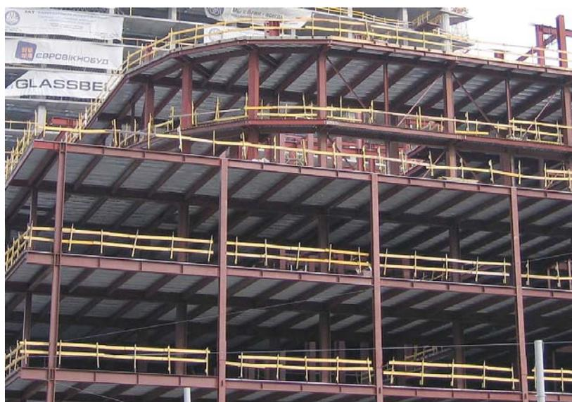
Рисунок 1.5.12 – Строящееся многоэтажное здание со стальным каркасом, г. Киев, Украина (фото Д. Д. Жукова); колонны и балки из двутавров; балочные клетки, состоящие из главных и второстепенных балок, опираются на колонны; по верху балок уложен стальной профилированный настил
