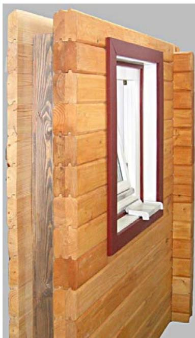
*Рисунок 1.2.12 – Энергоэффективная имитация брусчатой стены (фото Д. Д. Жукова)*
