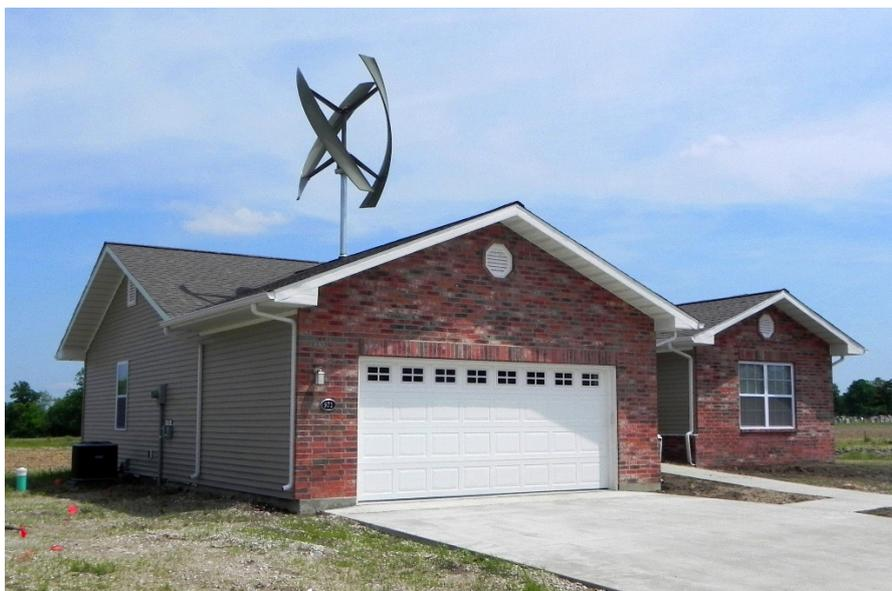
*Рисунок 1.2.3 – Net-zero energy building с ветроэнергетической установкой eddyGT номинальной мощностью 1 кВт в штате Иллинойс, США (фото компании Urban Green Energy)*
