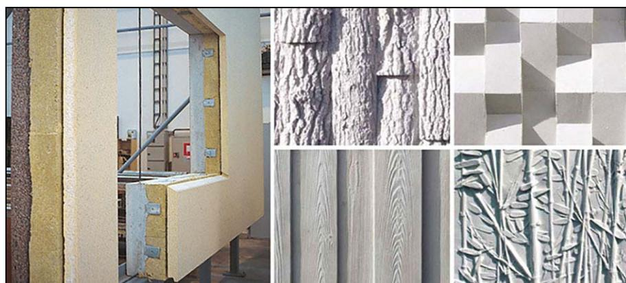
Рисунок 1.8.16 – Примеры крупной стеновой панели и отделки «Рекли» (компания Ветоніка, Литва)
