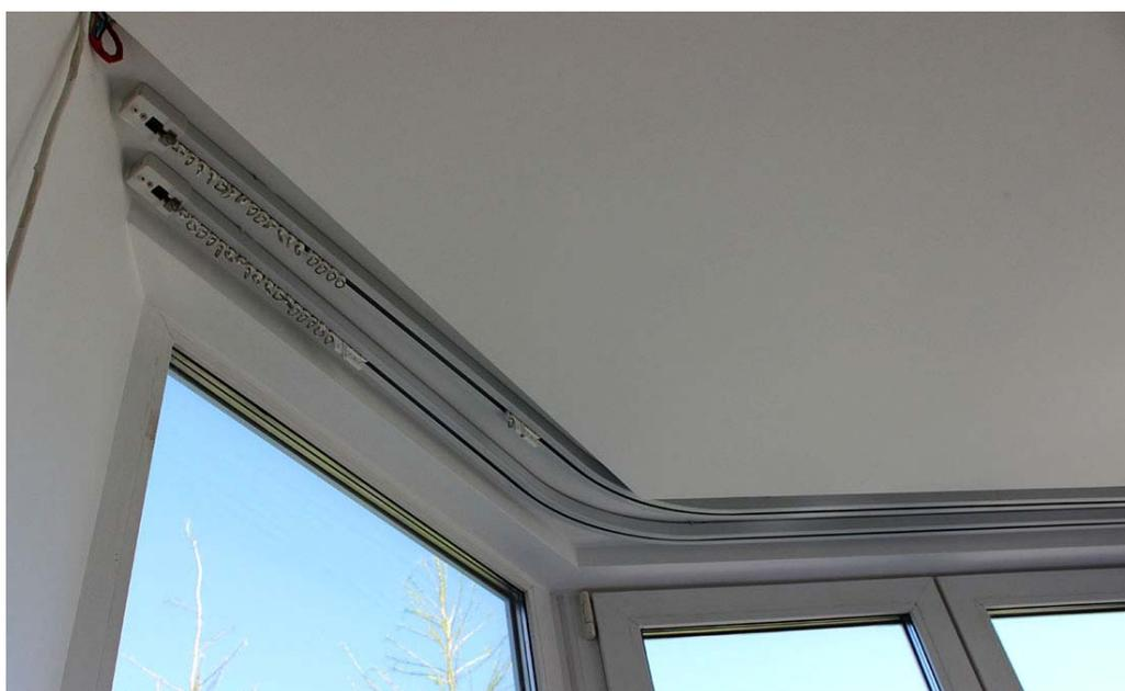
*Рисунок 1.3.15 – Окно, рядом с которым находятся потолочные направляющие для штор
