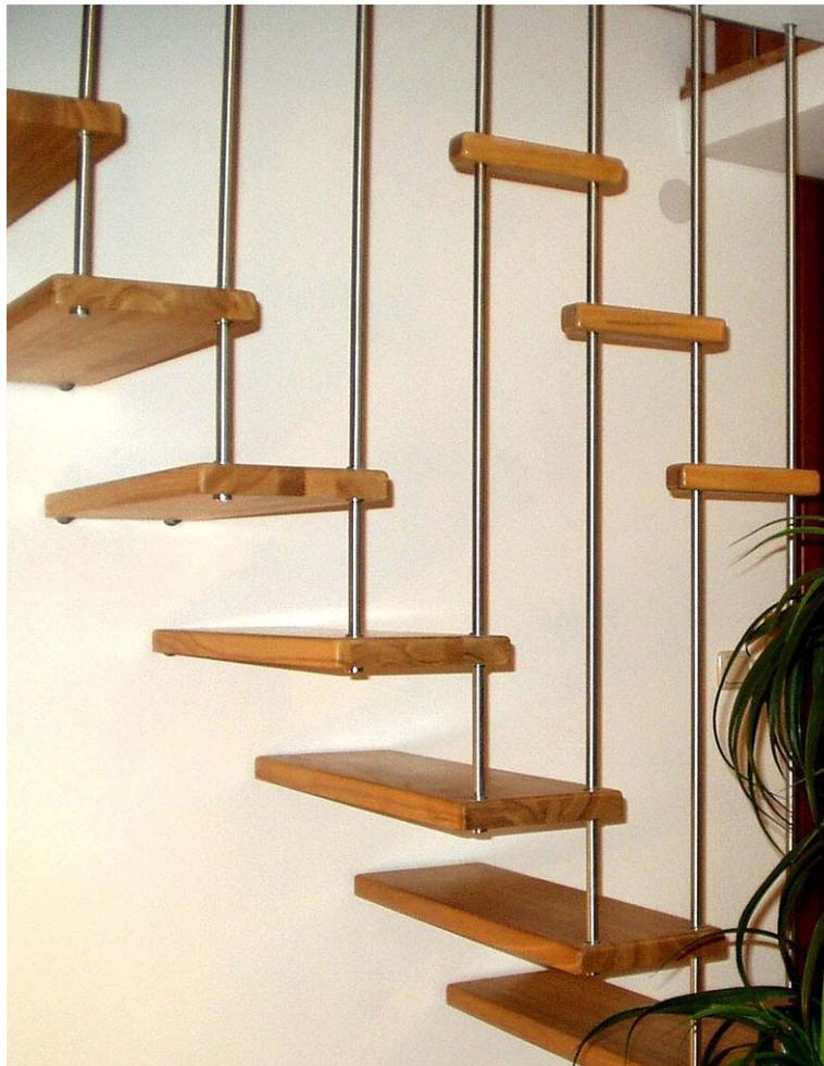
*Рисунок 1.2.26 – Лестница на подвешенных деревянных ступенях*
