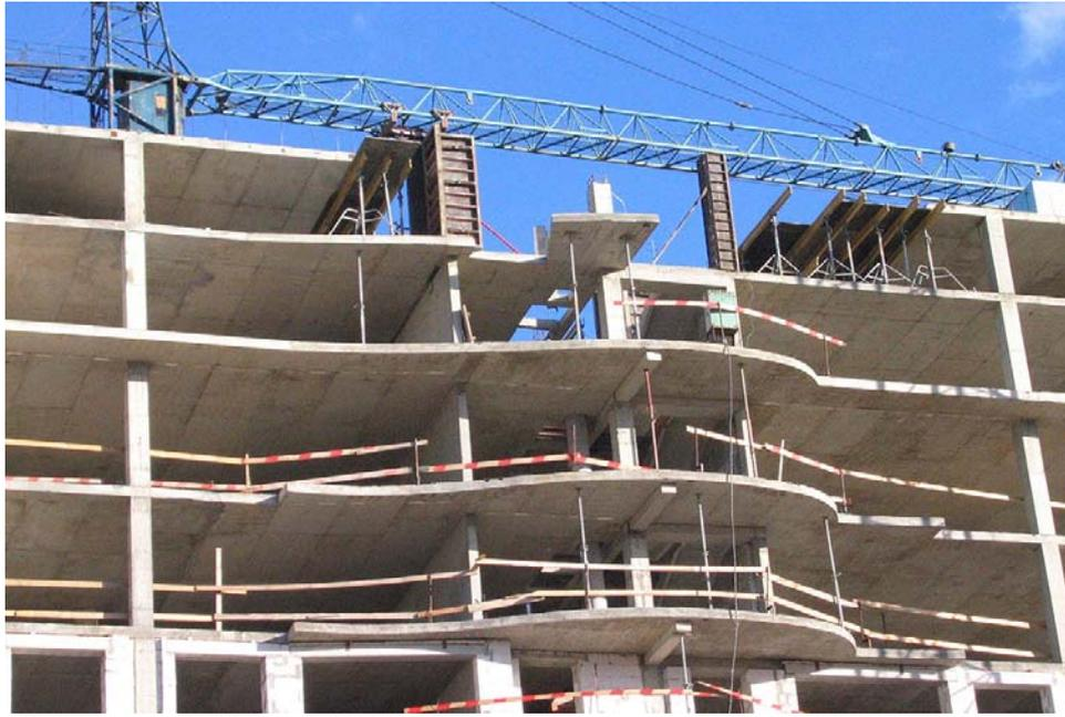
*Рисунок 1.1.31 – Многоэтажный жилой дом с монолитным железобетонным каркасом и плоскими дисками перекрытий в процессе строительства в г. Минске (фото Д.Д. Жукова)*
