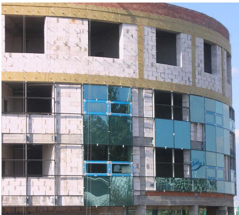
Рисунок 1.5.19 – Поэтажно опертые наружные стены на основе кладки из ячеистобетонных блоков, г. Минск (фото Д. Д. Жукова)
